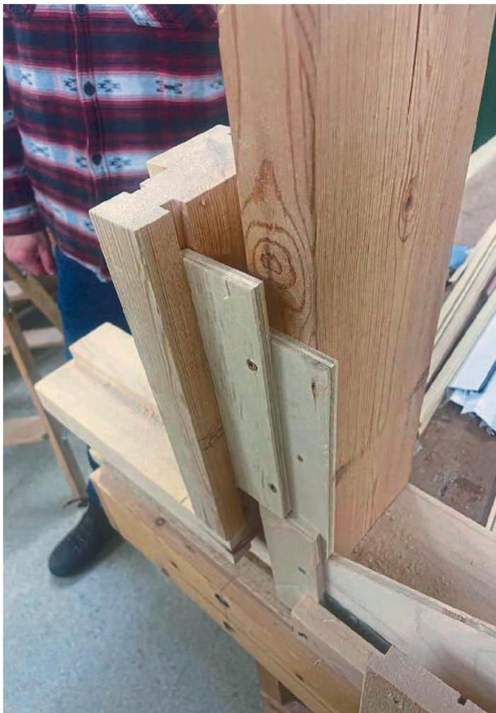
/ Nordische Prinzipien: Ein Modell zeigt die Konstruktionsdetails für die Montage der Fensterrahmen und die Anschlüsse der Verkleidung der Außenwand.
