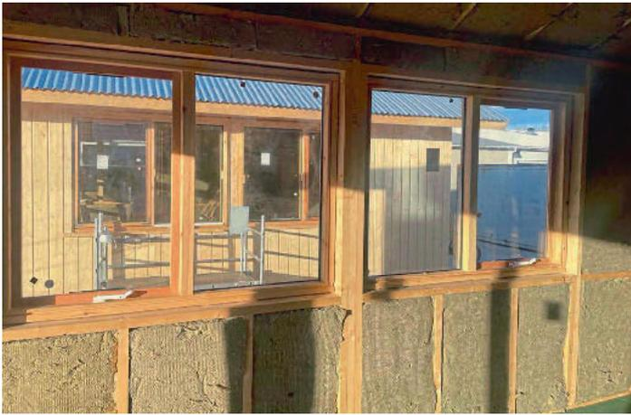
*/ Notwendige Wärmedämmung: Die Felder der Ständerkonstruktion der Tiny-Häuser werden von innen mit Steinwolle isoliert und anschließend beplankt.*
