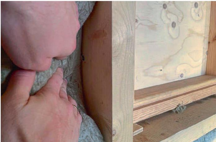
*/ Die Fensterrahmen der klassisch nach außen öffnenden Flügel werden vor dem Einbringen der Steinwolle – nicht sichtbar von außen – durch die Ständer befestigt.*
